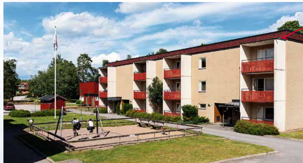
Envägen har bland annat fått nya tak på balkongerna
